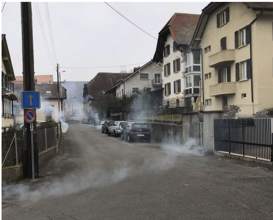
Exemple de fumée s'échappant des grilles de route
