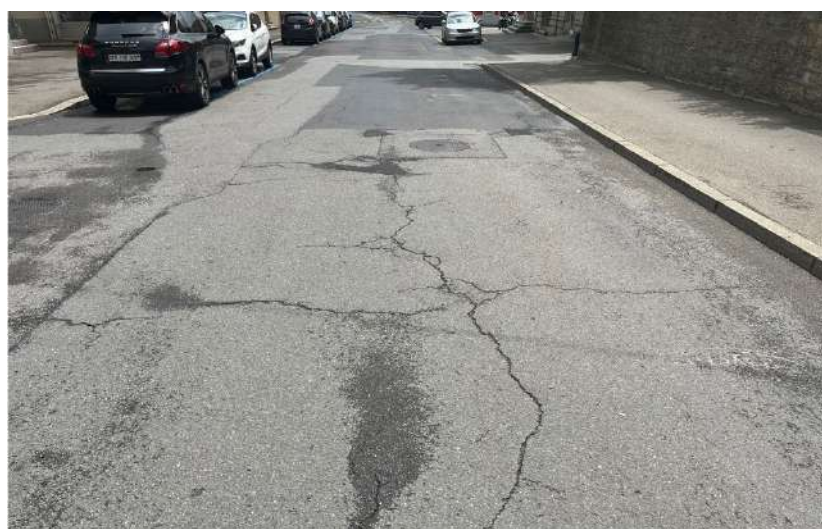
Rue du Temple, état des revêtements bitumineux
