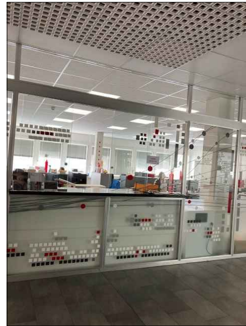
Vue depuis extérieur bureaux Greffe
