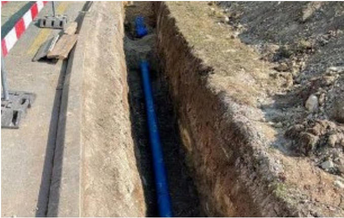
Avenues Général Jomini et du Stade, remplacement de la conduite
