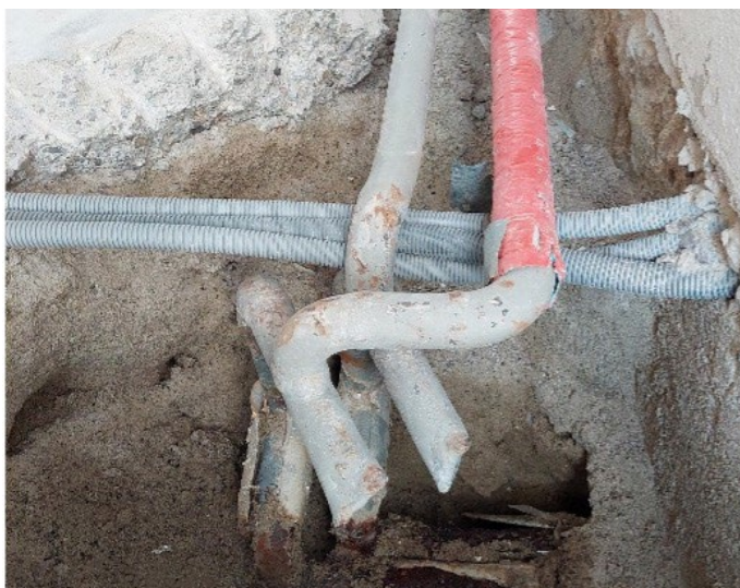
Remplacement de conduite du chauffage à distance
