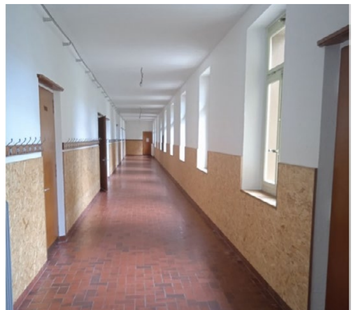
Rénovation du Pavillon des Rammes
