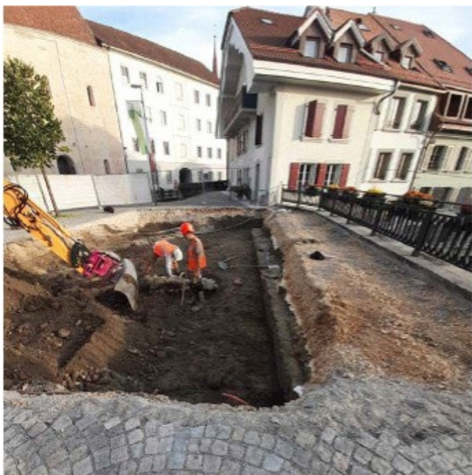
Aménagement d'une terrasse arborisée sur la Place du Marché
