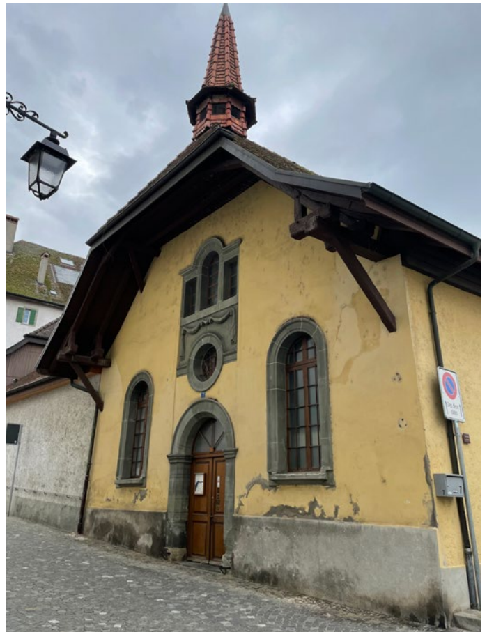
Ancienne église de la rue du Chemin Neuf 7
