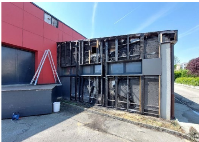
Réfection de la façade isolée Est de l'aile Nord suite à un début d'incendie accidentel
