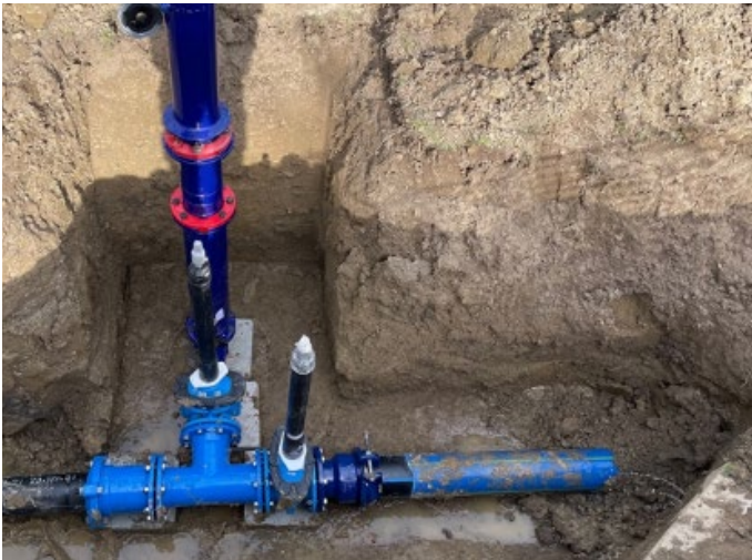
Avenues Général Jomini et du Stade, remplacement de la conduite et BH
