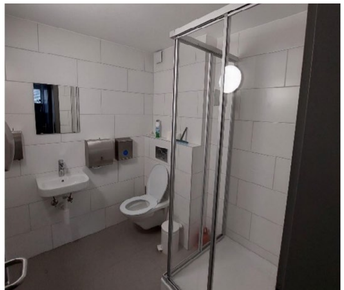
Réfection des sanitaires et ajout d'une douche au 3 e
