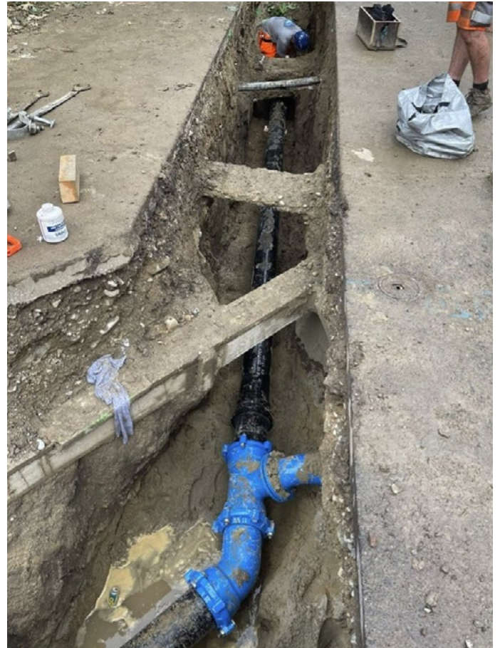
Avenue de La Promenade, remplacement de la conduite
