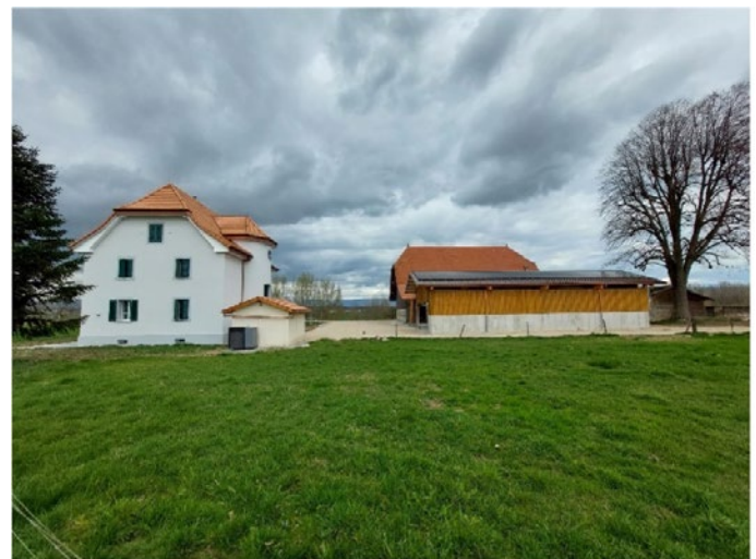
Habitation rénovée et nouveau rural de Grange de la Ville
